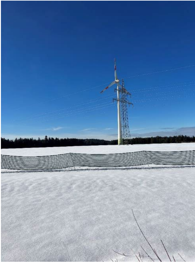
Abb. 9: Blick von Osten über das Plangebiet. Westlich davon ist eine Windkraftanlage gelegen. Eine 110kV-Hochspannungsleitung quert die Fläche.
