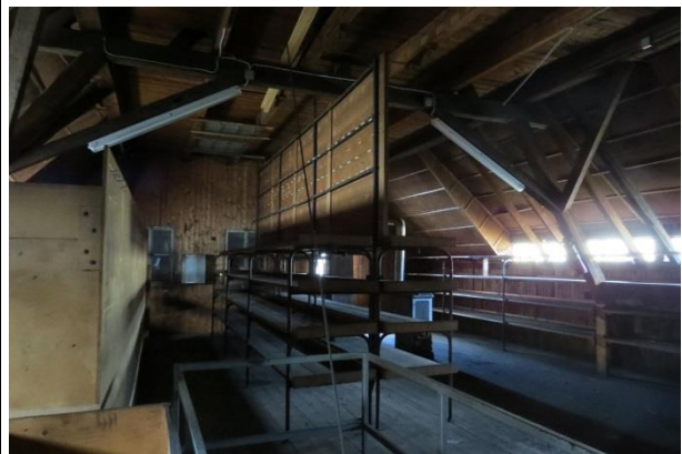
Dachräume Bestandsgebäude im Plangebiet (Foto: faktorgruen, 06.05.2020)
