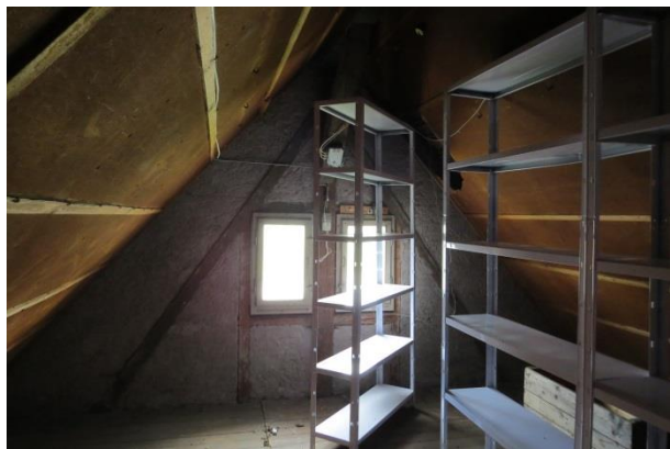
Dachräume Bestandsgebäude im Plangebiet (Foto: faktorgruen, 06.05.2020)
