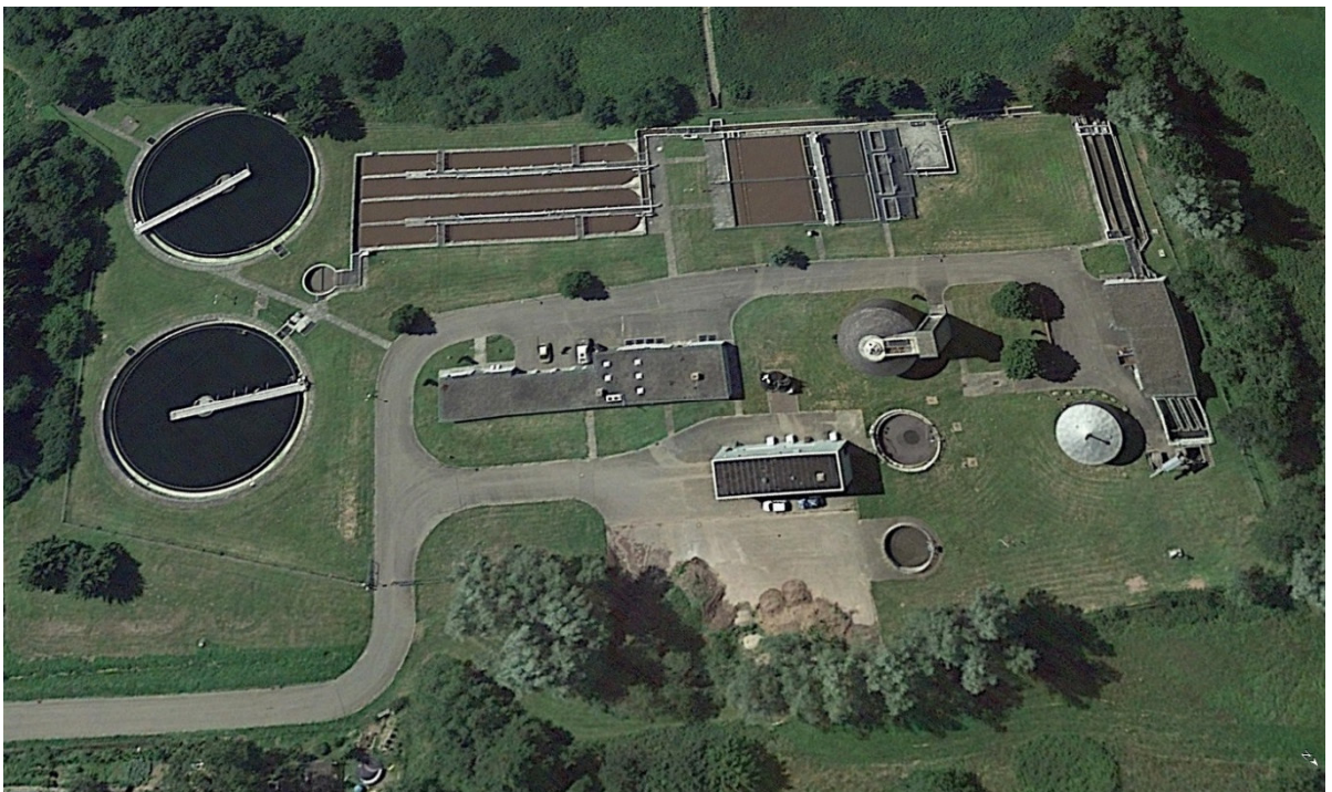
Abbildung 1: Luftaufnahme der Kläranlage St. Georgen-Peterzell
